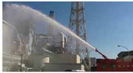
福島第一原子力発電所での放水作業。2013年3月撮影(Rikujoujeitai Bouei-sho)
